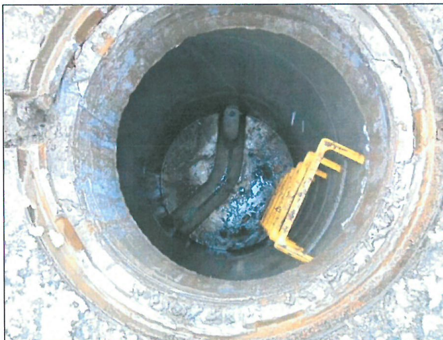
Zdjęcie nr 6. Studnia rozprężna Srp2 od pompowni P2, skrzyżowanie ul. Porzeczkowej i ul. Chmielowej i ul. Agrestowej w Kozach (Zadanie nr 3).
