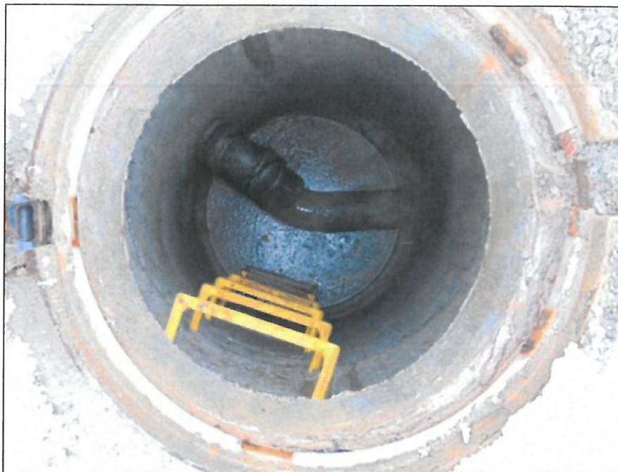
Zdjęcie nr 11. Studnia rozprężna Srp1, ul. Mostowa w Kozach, (Zadanie nr 3).
