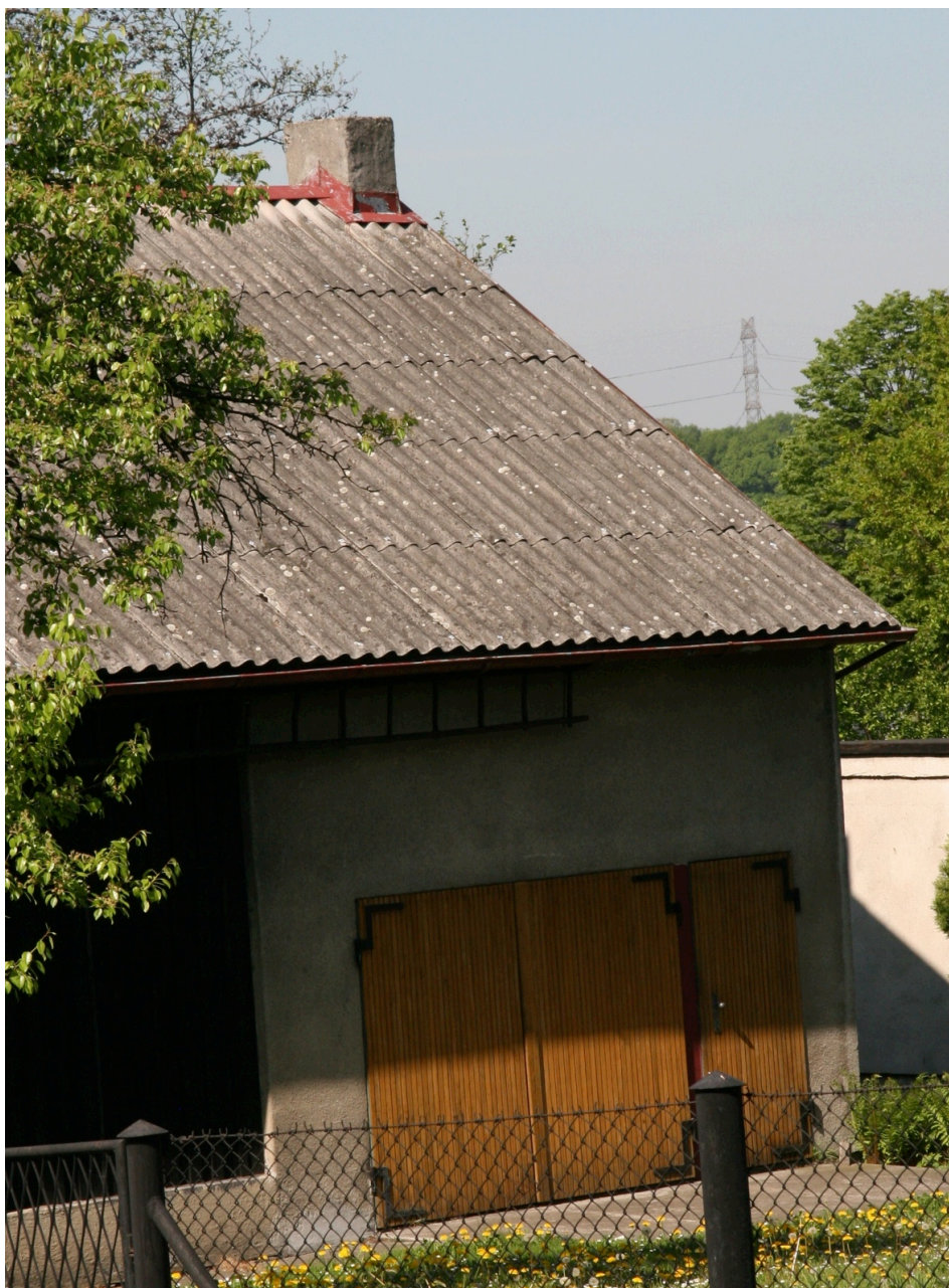
Rysunek 3 Dach pokryty płytami azbestowymi falistymi
