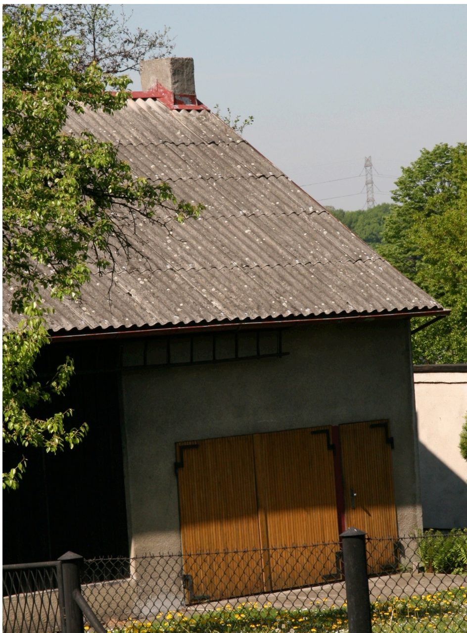
Rysunek 3 Dach pokryty płytami azbestowymi falistymi
