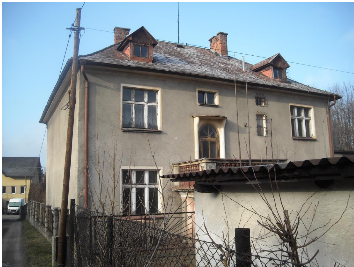
Rysunek 12 Dach pokryty płytami azbestowymi płaskimi (budynek przykładowy)
