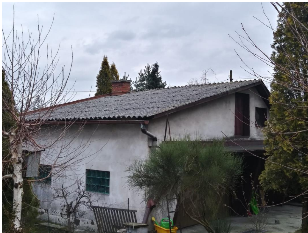
Rysunek 9 Dach pokryty płytami azbestowymi falistymi (budynek przykładowy)
