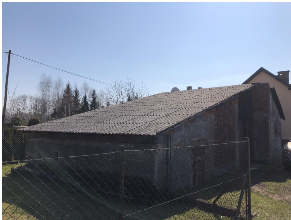
Rysunek 11 Dach budynku gospodarczego pokryty płytami azbestowymi falistymi (budynek przykładowy)
